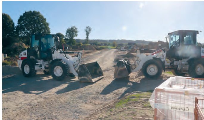
Zwischen Goldstraße und Mühlenstraße wird schon kräftig gebaut.
