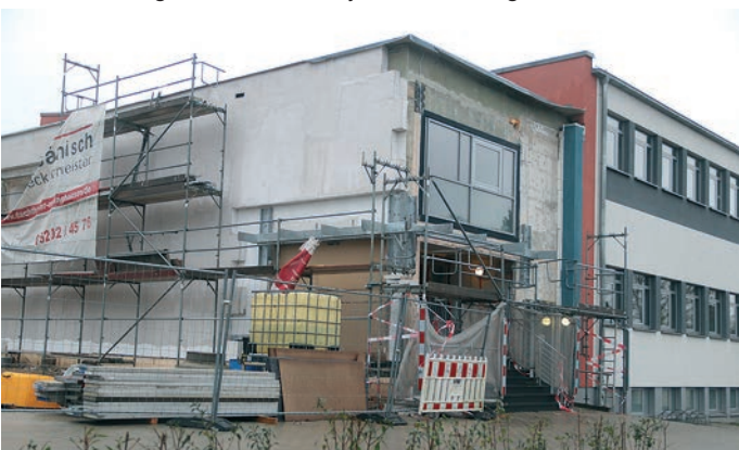
Der Eingangsbereich des Hallenbads wird derzeit barrierefrei gestaltet.
