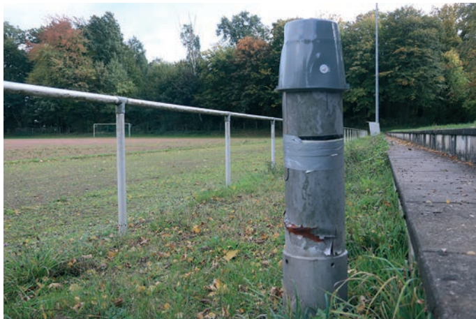
Die Schäden an den alten Masten sind unverkennbar.
