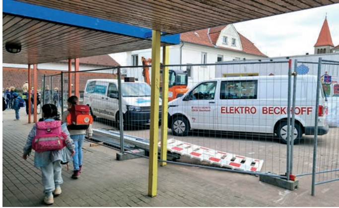
Für die Erweiterung wird demnächst das Flachdachgebäude der Grundschule abgerissen.
