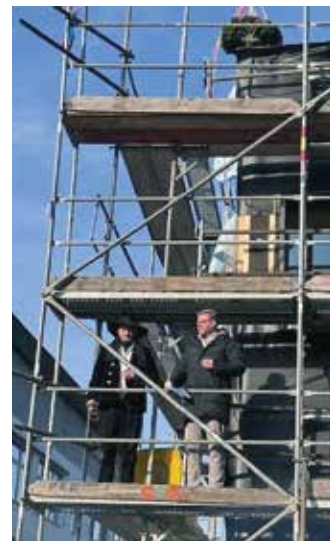
Kurz vor dem Richtspruch: Zimmermann Henrik Sonnenburger und Bürgermeister Peter Heepmann auf dem Gerüst des Erweiterungsbaus der Grundschule Helpup.
