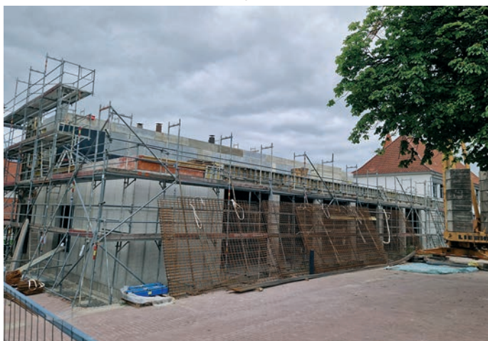
Die Bauarbeiten für die neue Mensa/Aula und die Verwaltungsräume liegen im Zeitplan.
